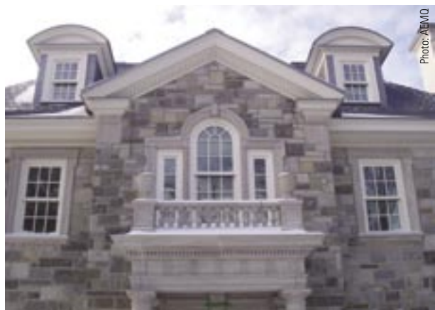
Résidence Steinmetz, à Westmount: Projet de l'année 2004 de l'AEMQ, catégorie Résidentiel léger (bâtiment neuf); architecte: Adam Borowczyk, Architettura; travaux exécutés par Rainville et Frères inc.; Commanditaire: Grani-Calcaire inc.
