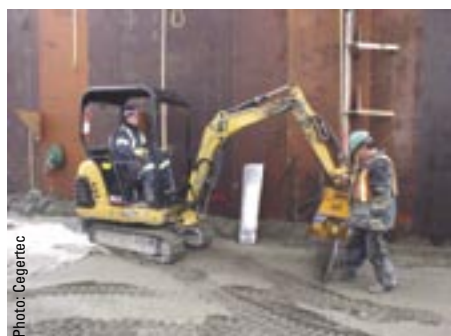
Photo du haut: déversement et mise en place du BCR à l'aide d'une pelle hydraulique. Photos du centre et du bas: pose des joints.
