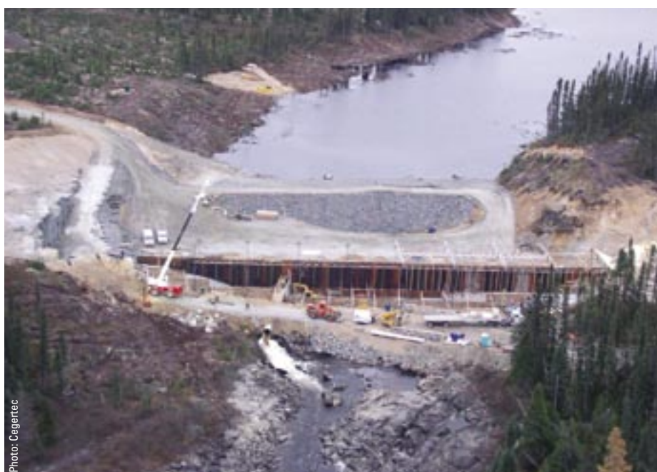
Photo du haut et du bas: barrage et batardeau sur la Manouane.
