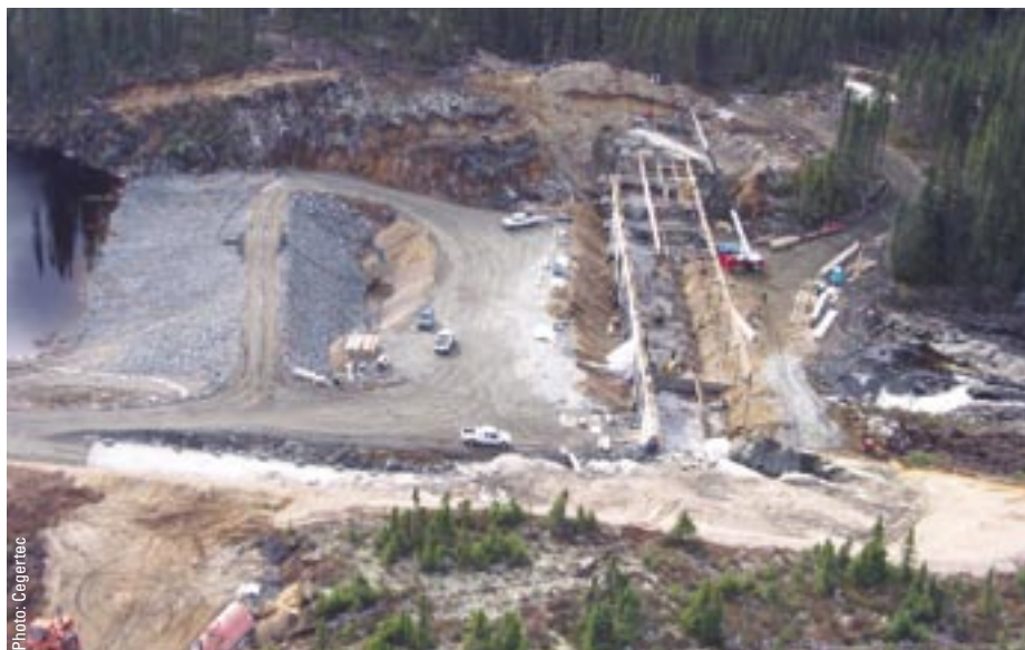
Photo du haut et du bas: barrage et batardeau sur la Manouane.
