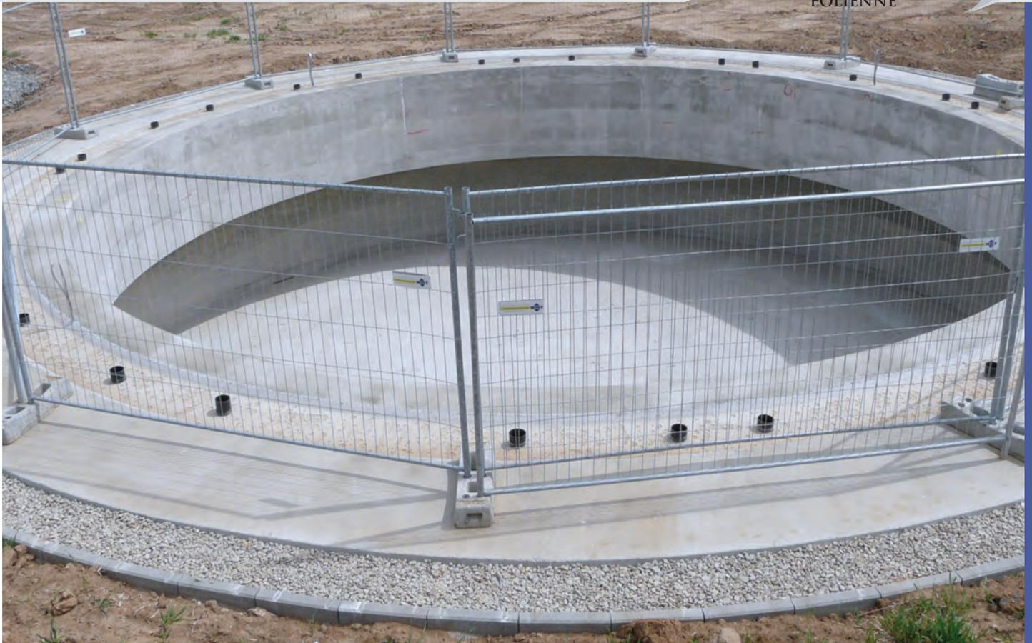
L'installation d'une tour de 98 m de hauteur commande la coulée d'une fondation d'environ 600 m<sup>3</sup> de béton dans le sol. La fabrication d'une tour en béton, quant-à elle, nécessite 290 m<sup>3</sup> de béton et 54 tonnes d'acier.
