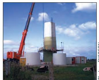
Les moules à béton préfabriqué, les sections et l'assemblage d'une tour d'éolienne.
