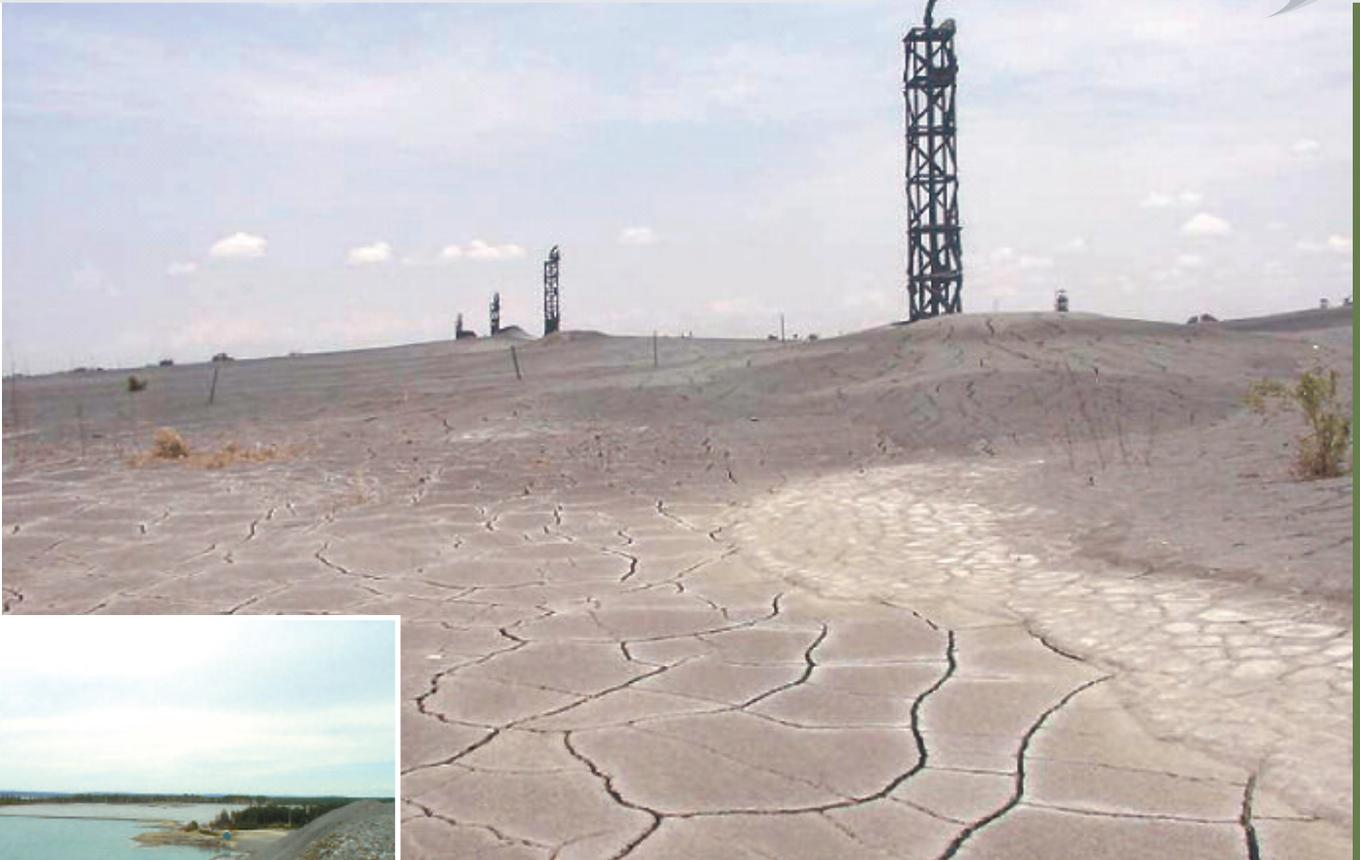
◀ Stockage sous eau de rejets de concentrateur dans une mine polysulfurées avec des digues de retenue.
