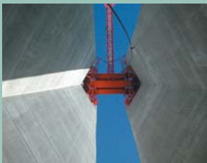
▲ Les piles du viaduc de Millau ont demandé 85 000 m 3 de béton, dont 50 000 m 3 en béton haute performance.
