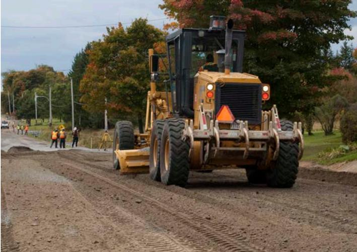
stabilisée au ciment. Cette étape est réalisée quelques jours après la compaction finale de la fondation. «L'asphalte est surtout épandu pour assurer une bonne qualité de roulement pour les automobilistes, dit M. Poirier. Ces derniers roulent ainsi sur une surface d'asphalte sans savoir qu'il y a en réalité du ciment en dessous.»
