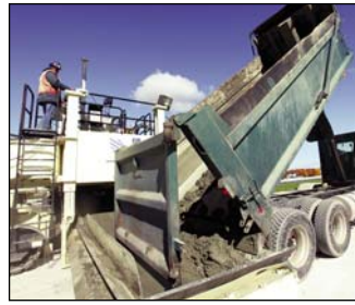
Le béton prêt à l'emploi a été fabriqué dans l'usine mobile installée près du chantier.
